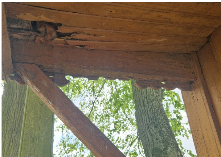
Fot. 4 Drewniana kapliczka w Przechodzisku, stan przed konserwacją 2024r, zbliżenie zniszczeń podbitki ganku.
