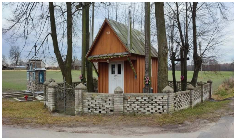
Fot. 1 Drewniana kapliczka w Przechodzisku, stan przed konserwacją 2024r, widok ogólny.
